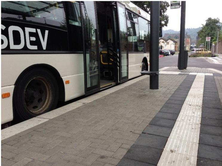
Abbildung 26: Bodenindikatoren an einer Haltestelle mit Begleitstreifen (Bildquelle STUVA)
